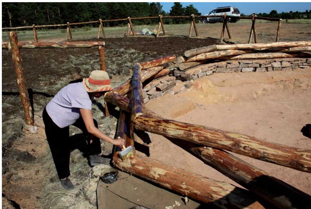
5-сур. Ағаштан тұрғызылған қабырғаны сақтау шаралары. Сурет Ж.К. Сұлтанжановтікі Fig. 5. Preservation measures for a wall built of wood. Photo by Zh. Sultanzhanov Рис. 5. Меры по сохранению стены, возведенной из дерева. Фото Ж.К. Сұлтанжанова
