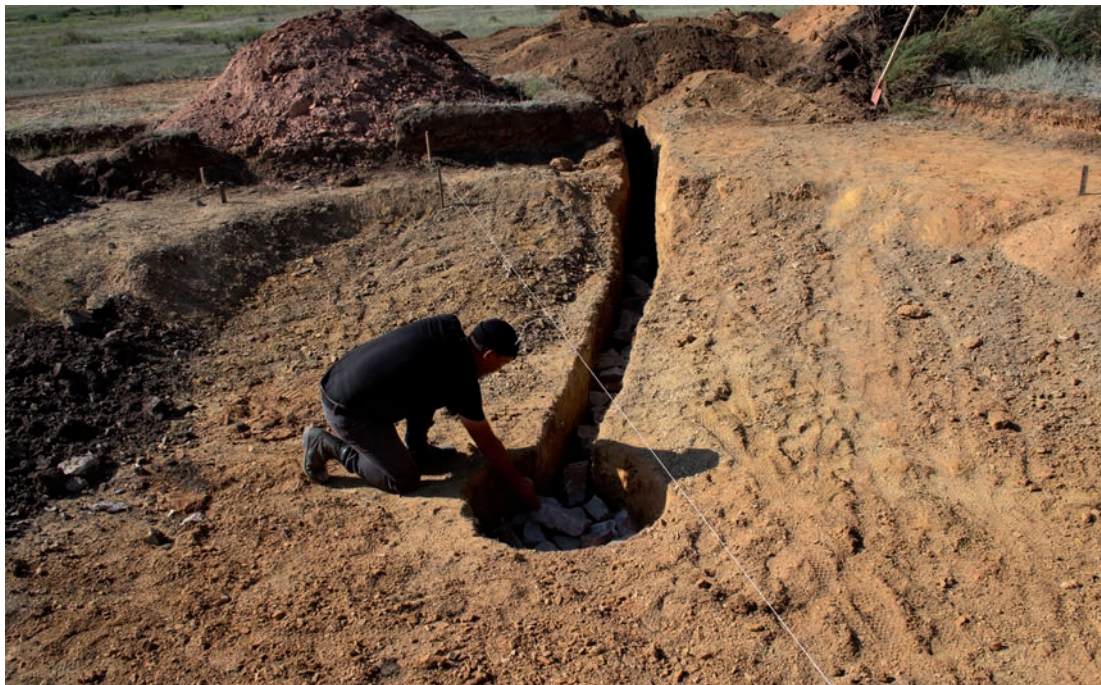
3-сур. Дренажды жүйені құру барысы. Сурет Ж.К. Сұлтанжановтікі Fig. 3. The process of creating a drainage system. Photo by Zh. Sultanzhanov Рис. 3. Процесс создания дренажной системы. Фото Ж.К. Сұлтанжанова
